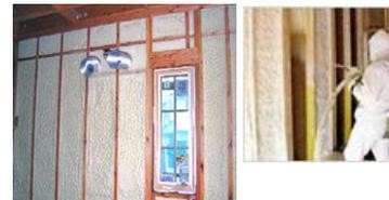
ダクトや配管などの隙間が出やすい部分にもしっかり充填することで気密性を確保します。
