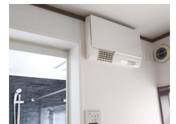
洗面所暖房機を設置 冬の寒さしのぎます
