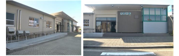
正面入り口にスロープを新設しました！
