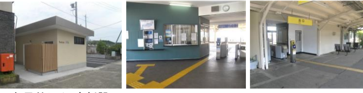
多目的トイレも新設 改札口からホームへ
