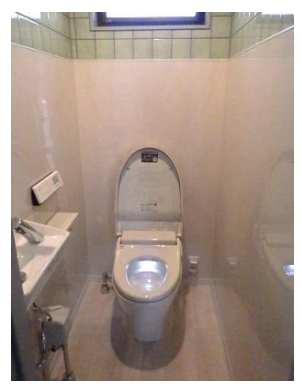
床はクッションフロアに 壁は汚れを拭き取りやすい パネル貼りにしました
