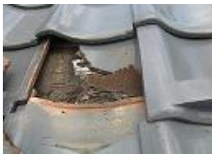
〈瓦が割れた状態〉
